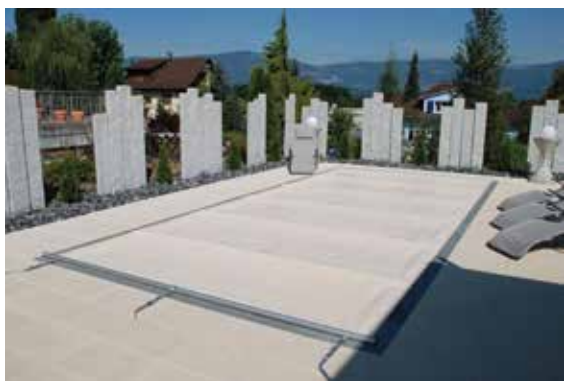
Illustration 34 : couverture flottante de bassin extérieur
