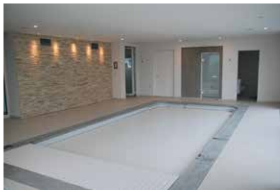
Illustration 35 : couverture flottante de bassin intérieur
