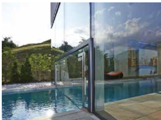
Illustration 24 : Portes coulissantes immergées pour accéder à la piscine extérieure
