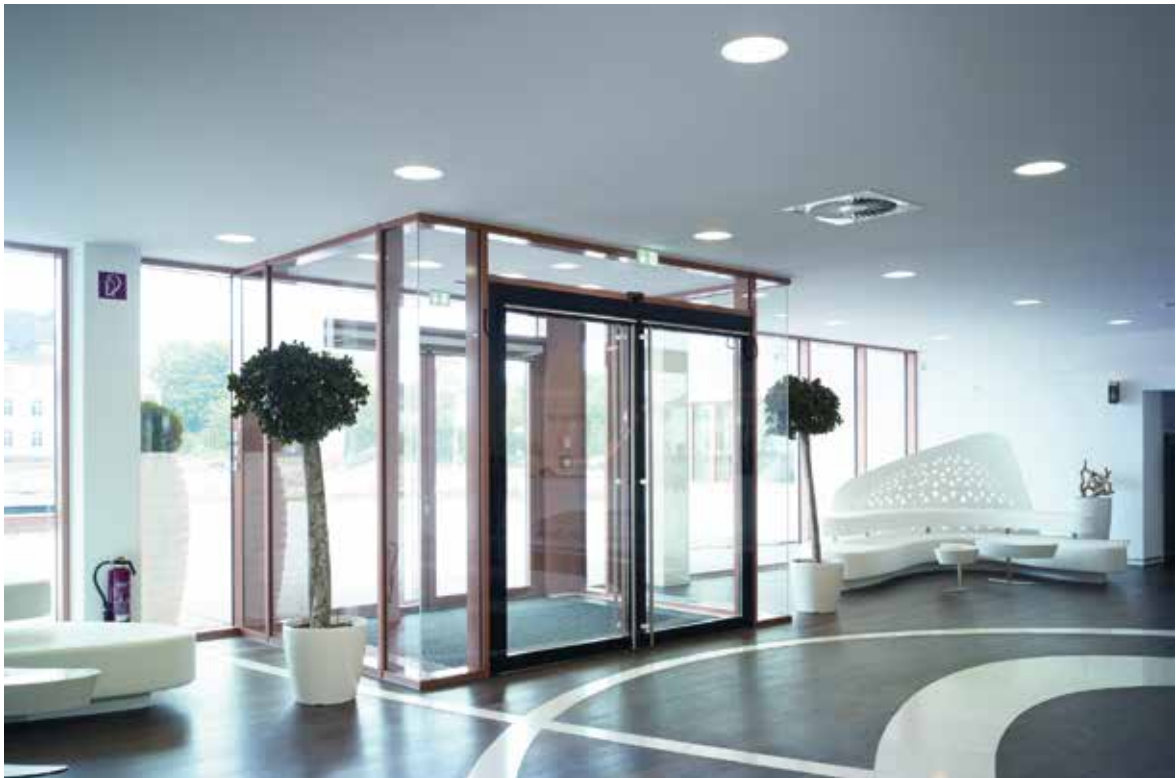
Illustration 22 : Sas d'entrée avec deux portes coulissantes
