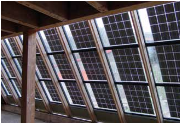
Illustration 11 : Éléments photovoltaïques intégrés dans le toit en verre
